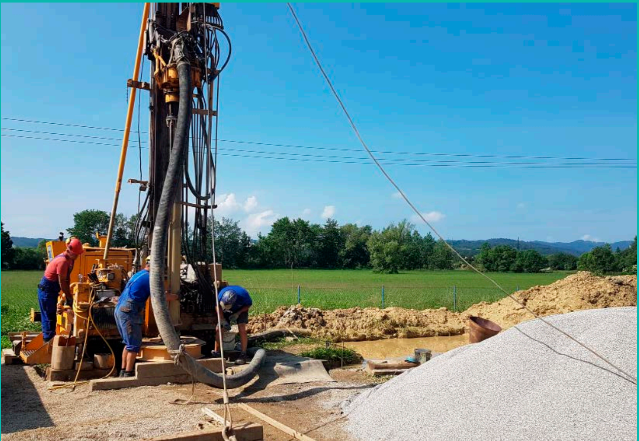
Realizace průzkumného vrtu Lesnice u Zábřeha
