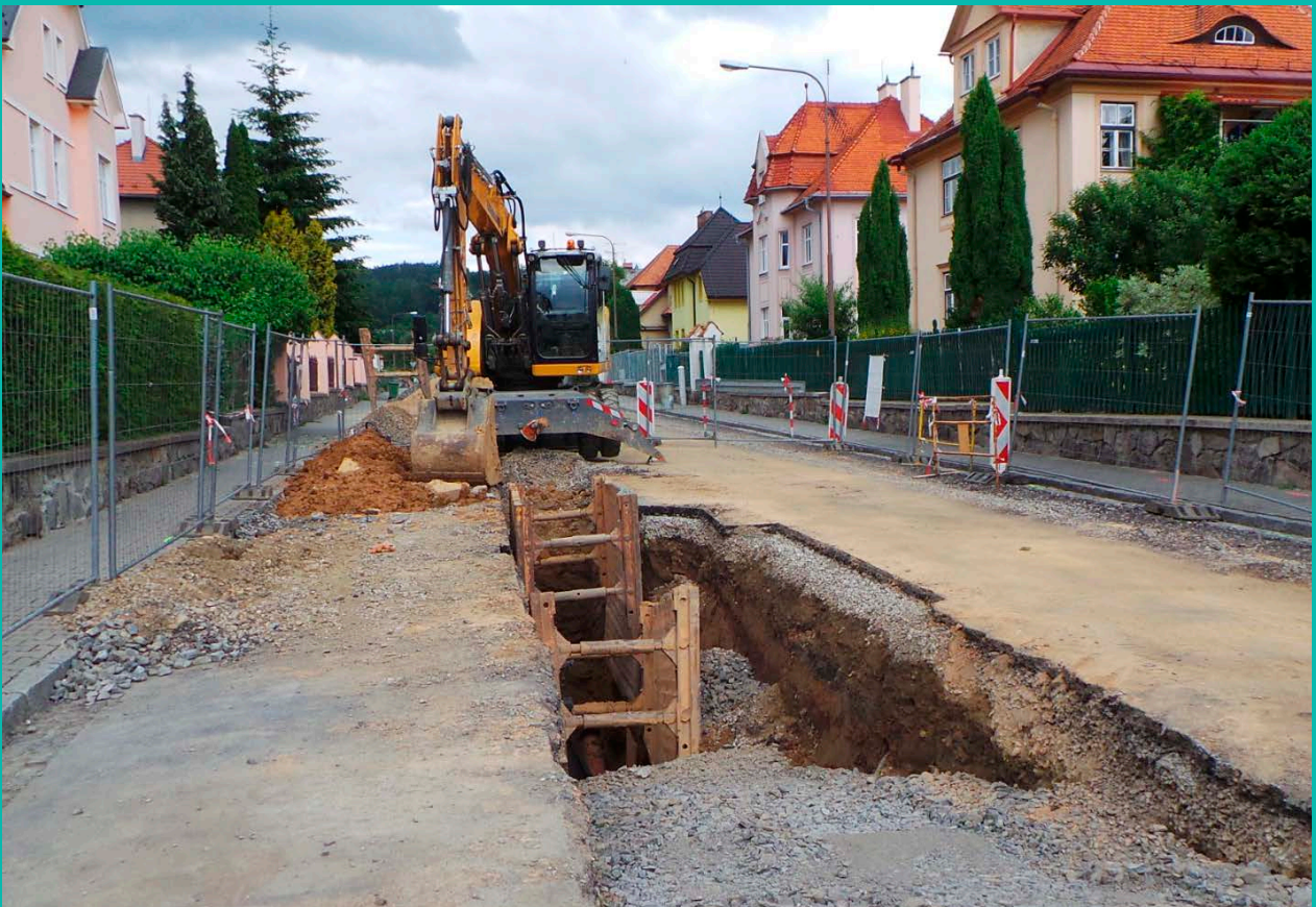
Obnova vodovodu a kanalizace v ulici Jánošíkova v Šumperku
