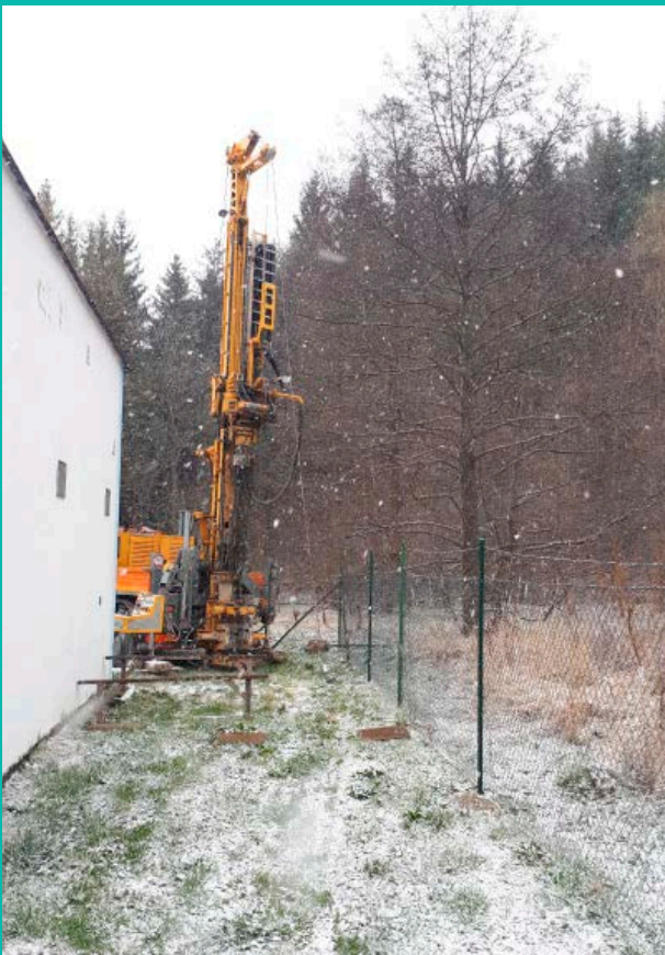
Realizace průzkumného vrtu v obci Svojanov u Maletína
