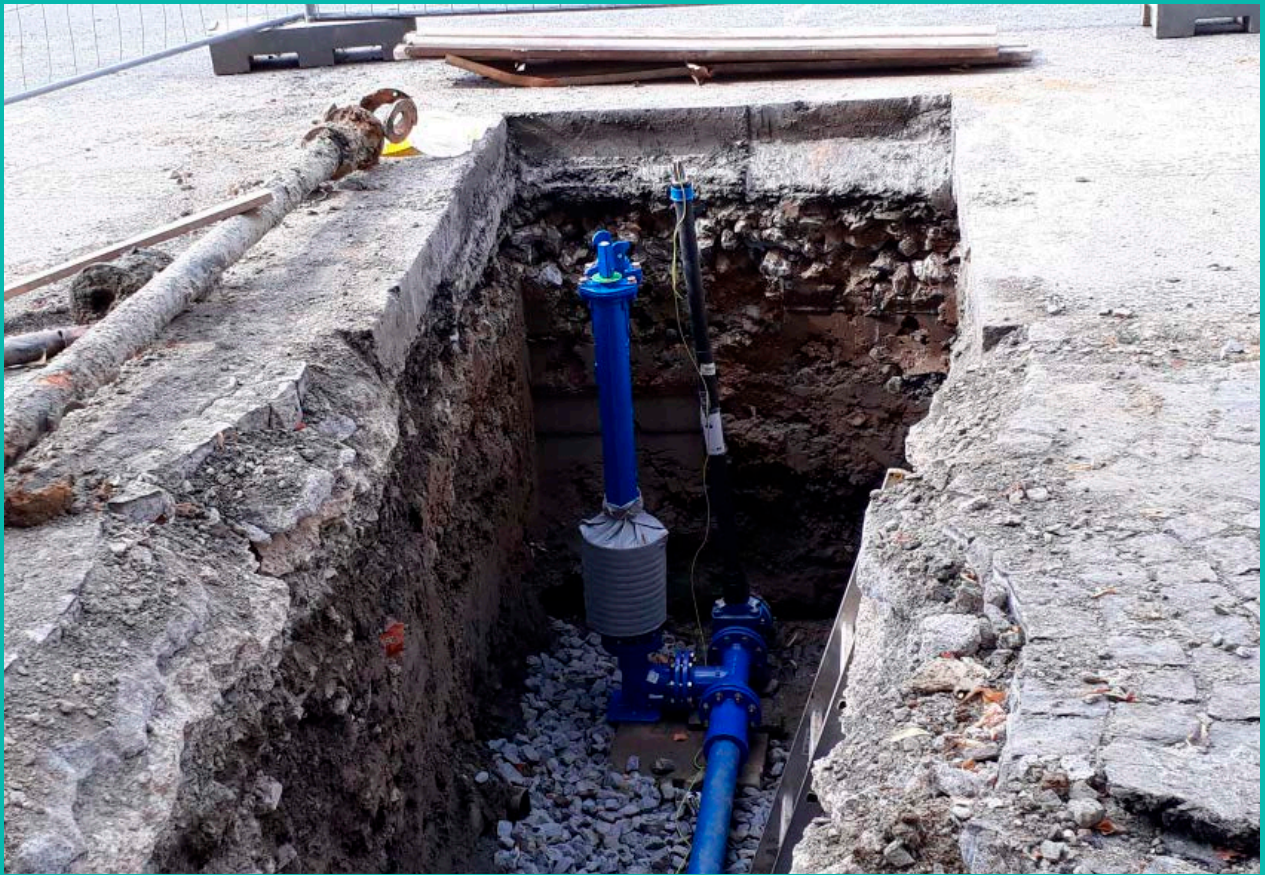
Obnova vodovodu a kanalizace v ulici Čajkovského v Šumperku
