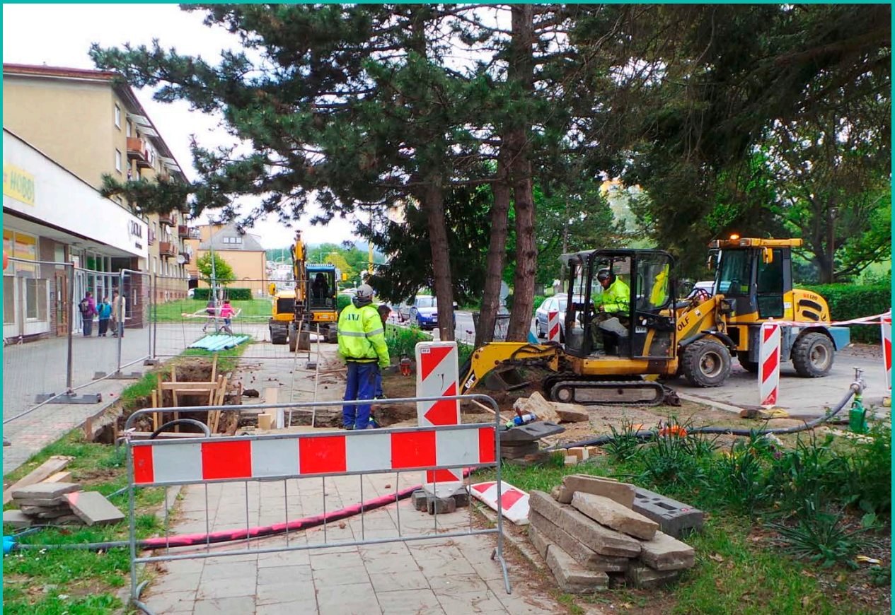
Obnova vodovodu a kanalizace v ulici ČSA v Šumperku
