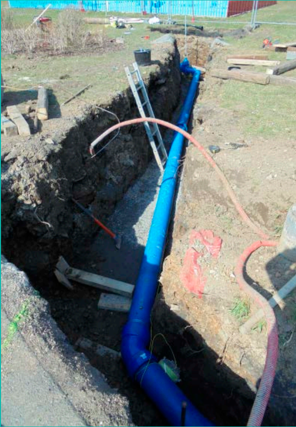
Obnova a vymístění velkokapacitního vodovodu v ulici Vodní v Mohelnici
